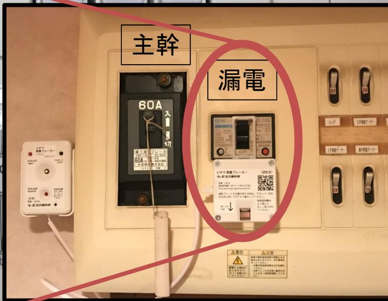
遮断部の設置可否の確認をするために必ず分電盤の漏電ブレーカーの周辺を見てください。このとき、主幹ブレーカーと漏電ブレーカーを間違わないよう注意してください。**※地域によっては「主幹」のない分電盤もあります。**
